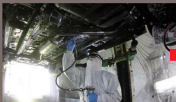
アンダーカバーを取り外して水性密封剤「ブラック」を塗布(約1.5~2ℓ)
